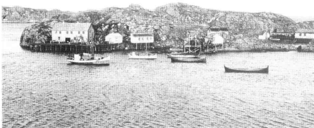
I begynnelsen av 20-årene ble det for tungvint å drive fiskekjøp på Husjord. I 1925 ble det derfor bygd et større og mer tidsmessig fiskebruk på Bårholmen.
